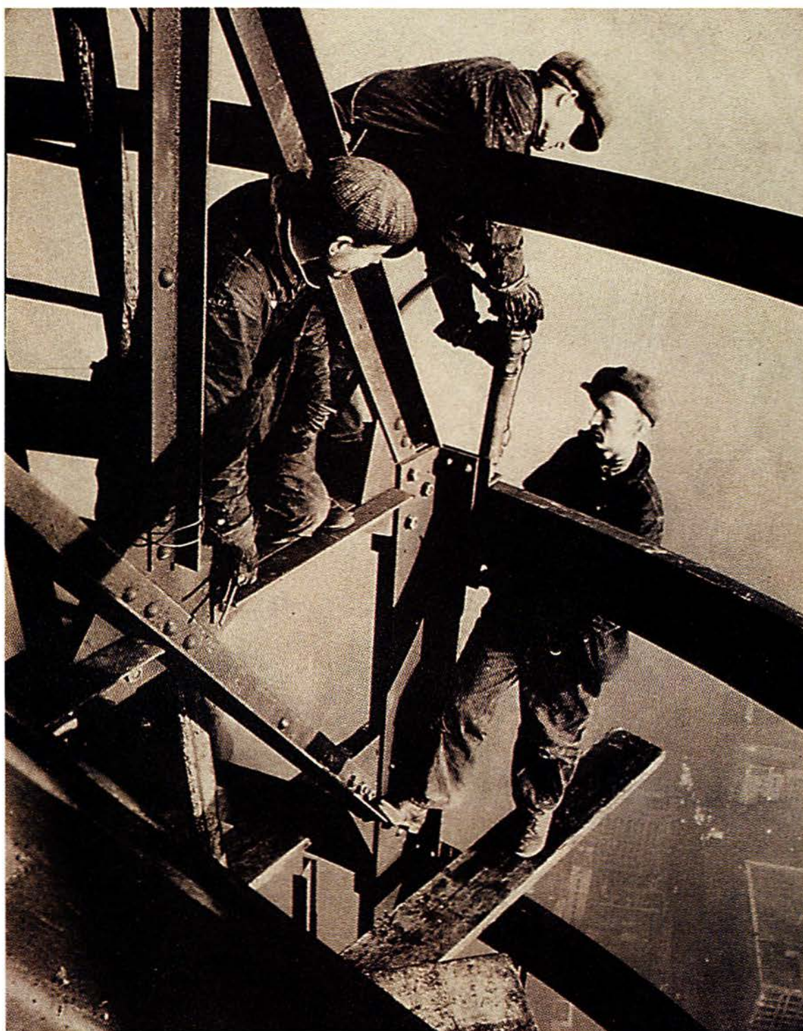
Remachadores en la cúspide del Empire State Building, 1931.
