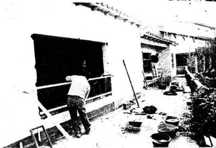
Foto Ventanales de hormigón prensado. Colocación.
